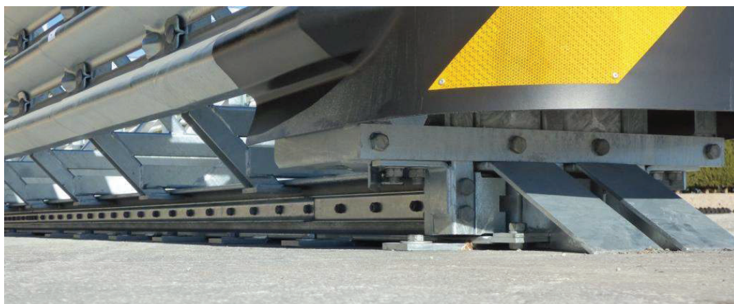
Atenuador fixado com parafusos de ancoragem TSM-A22x155 (abaixo das placas de ancoragem), parafuso M16x40 DIN933 e arruela M16 DIN9021
