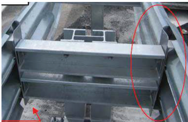
Sobreposição das lâminas de transição AIR H120P, H110P, H100P, H80P e H50P
