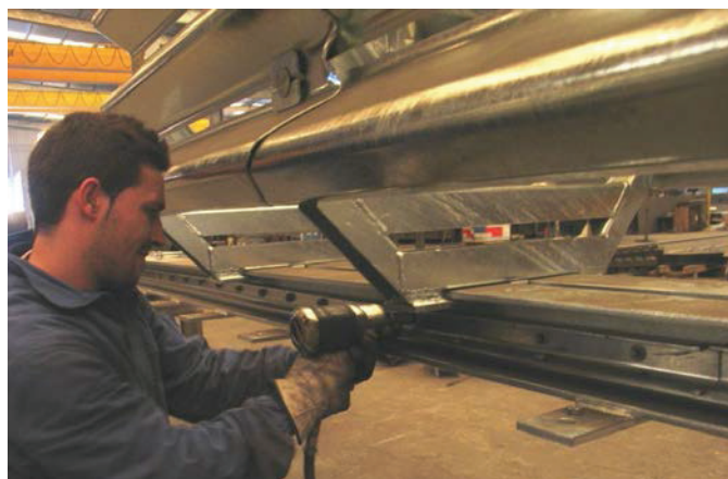
Colocação dos perfis absorvedores
